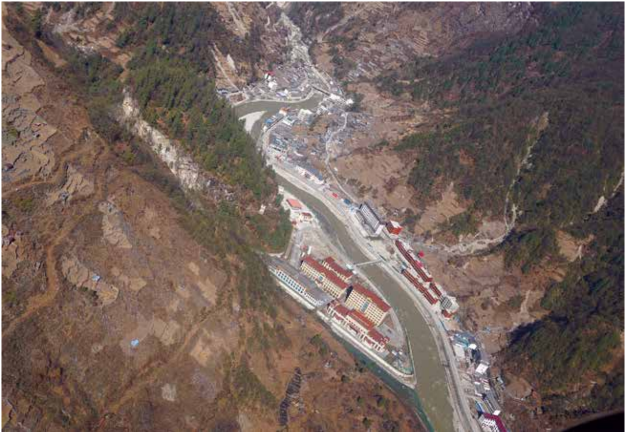
निर्माणाधीन अपर अरुण जलविद्युत आयोजनाको कर्मचारी आवास
